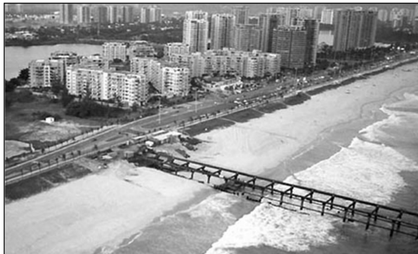
O emissário submarino da Barra da Tijuca, que lança em alto-mar 900 L/s de esgoto, que antes eram lançados nas lagoas da região.
