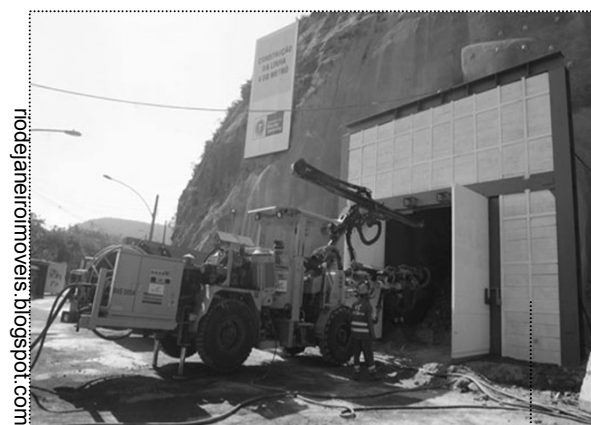
Canteiro de obras da Estada da Gávea
