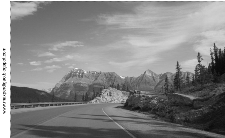
Trecho da rodovia Transcanadá
