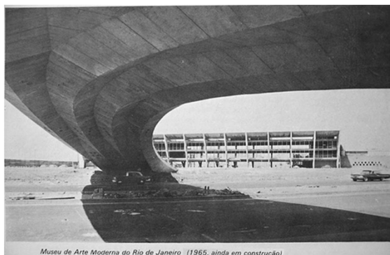
Museu de Arte Moderna do Rio de Janeiro (1965, ainda em construção)
