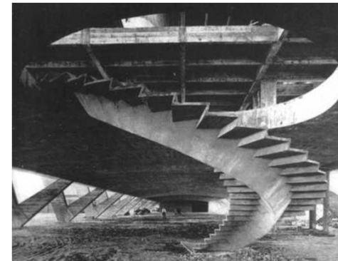
Escada do MAM, em construção, 1965.
